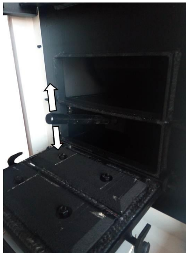
Slika 19. Čišćenje turbulatora na kotlu
