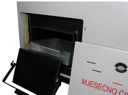
Slika 17 i 18. Čišćenje otvora ispod konvektivnog snopa
